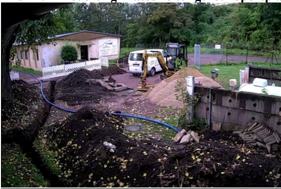
Bild 11: Erneuerung Wasserleitungsnetz Sportplatz
